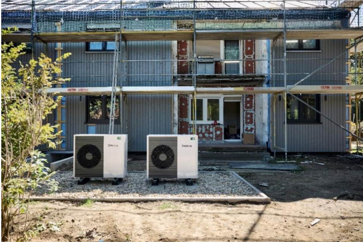
Foto: Die Sanierung von Mehrfamilienhäusern mit Wärmepumpe ist in Mönchengladbach zu einem Leuchtturmprojekt geworden. /Vaillant Deutschland
